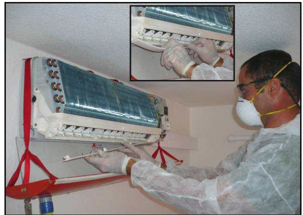
Placer la gouttière sous l'appareil en réglant la sangle suivant sa taille puis ôter les volets horizontaux
