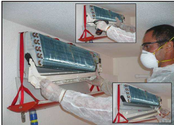
Démonter le bac de condensat des 2 cotés en veillant à ne pas déconnecter le tuyau d'évacuation
