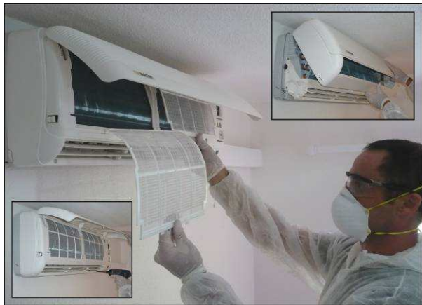
Oter les filtres et le capot principal en dévissant les vis de maintien
