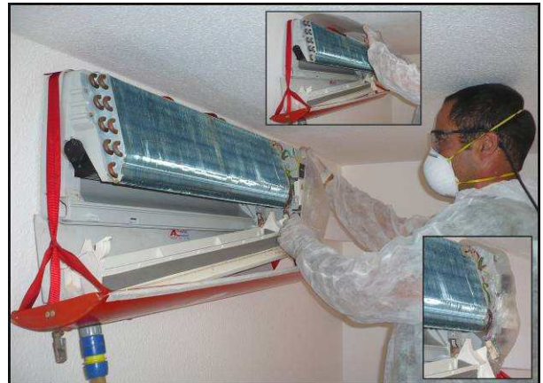
Protéger la partie électrique à l'aide de la charlotte plastifiée, puis placer la plaque de protection contre les éclaboussures sur la partie supérieure de l'appareil
